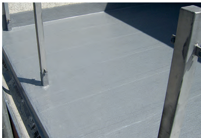
• Dvignjenih gradbenih elementov
